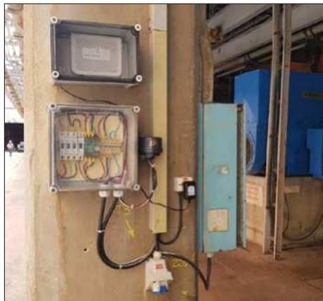
Рис. 1 — Выберите свободное пространство с хорошим сигналом GSM. Бетонный столб может блокировать все сигналы. Идеальное место для шлюза — высоко внутри здания, без помех от стен.
