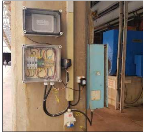
Abbildung 1 – Eine freie Fläche mit gutem GSM-Signal wählen. Der Betonpfeiler könnte alle Signale blockieren. Der ideale Platz für das Gateway ist hoch oben im Gebäude, wo es keine störende Wand gibt.
