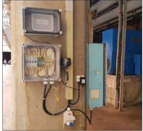
Fig. 1 – Selecione uma área livre com bom sinal GSM. O pilar de concreto poderia bloquear todos os sinais. O local ideal para o gateway é na parte alta do edifício, sem interferências nas paredes.
