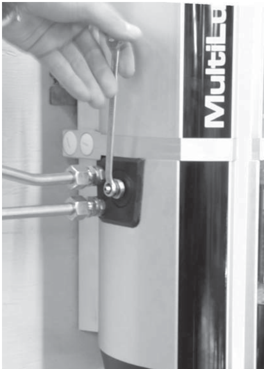
Figur 1. Öppning av luftningsskruv
